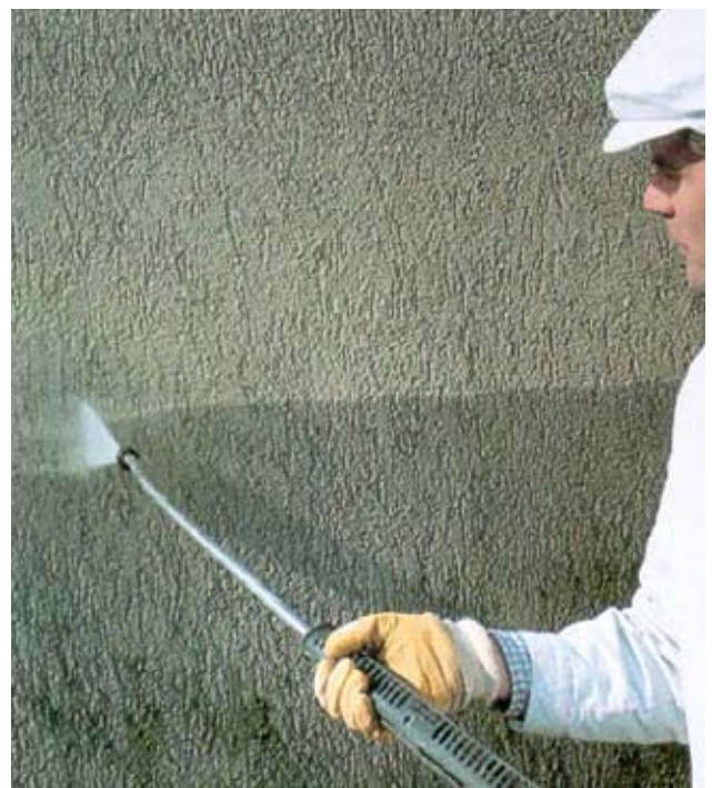
Abb. 10: Vorbereitende Maßnahmen an einem befallenen Objekt
